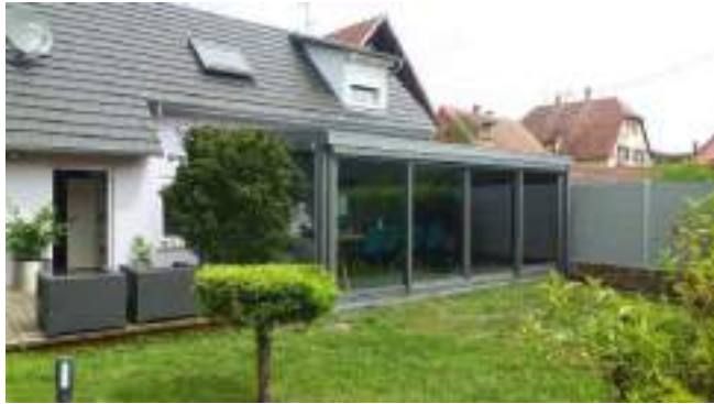
Les murs pleins en fond
